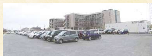
増設した駐車場
